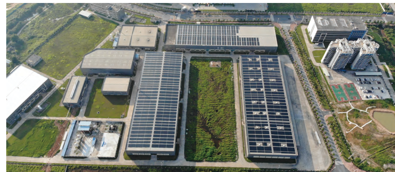
■ 清远4.8MW屋顶光伏电站
