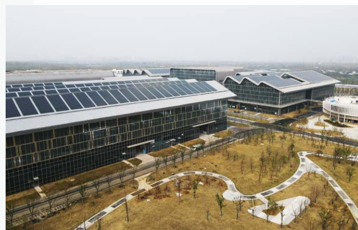
■ 国家大科学装置核聚变堆研究基地2.77MW电站
