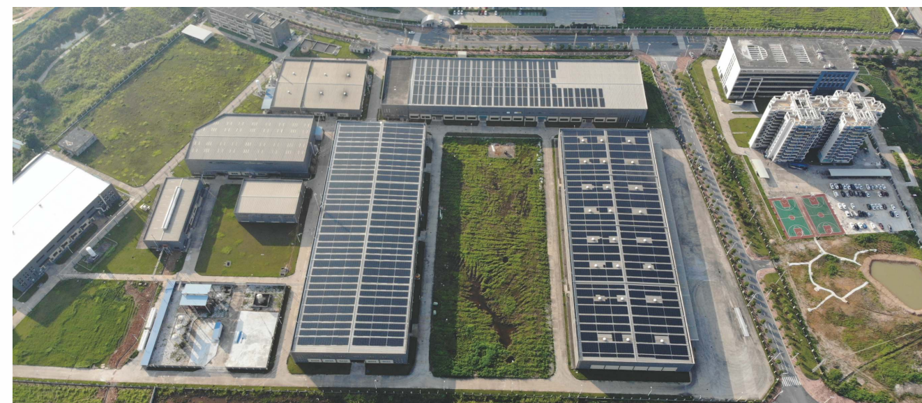
■ 清远4.8MW屋顶光伏电站
